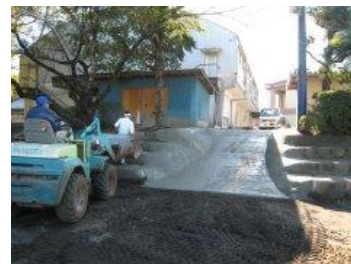
【コンクリートで固める作業】
