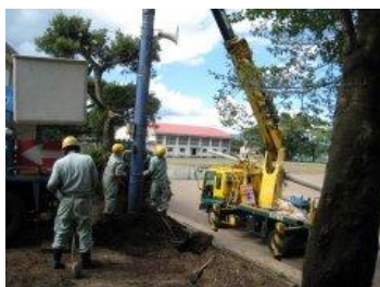
【電柱の移動作業】
